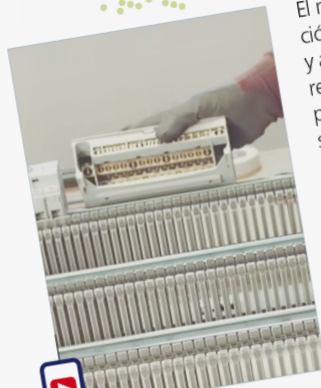
Fig. 2.22. Montaje del cuadro eléctrico.
